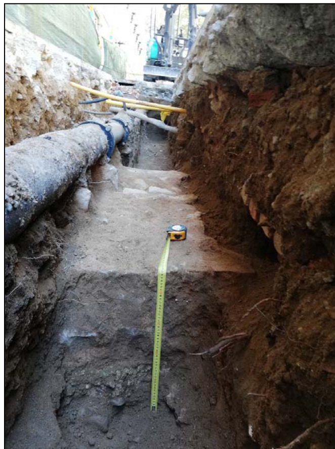
Fotografia 8. Perfil i potència del mur UE 2004, des de sud
